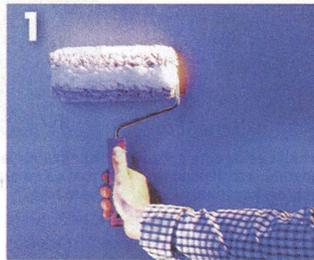
1 Клей наносят не на обои, а на оклеиваемую стену.
