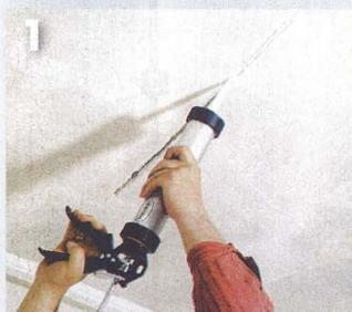
Мелкие трещины на потолке расширяют и после нанесения грунтовки заделывают эластичным составом.
