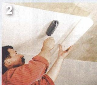
Наносят клей на потолок, прикладывают к нему обои и прикатывают сухим твёрдым валиком.
